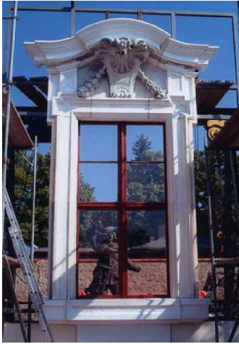
Aufbau des ersten Schlossfensters
