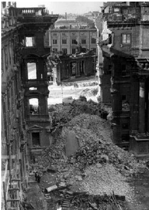
Kriegsruine des Berliner Schlosses; Sprengung der Südwestecke 1950
